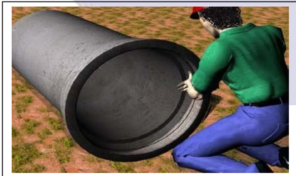
Figura 2 - Lubrificação do anel de borracha
