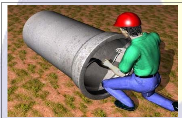
Figura 1 - Colocação do anel de borracha
