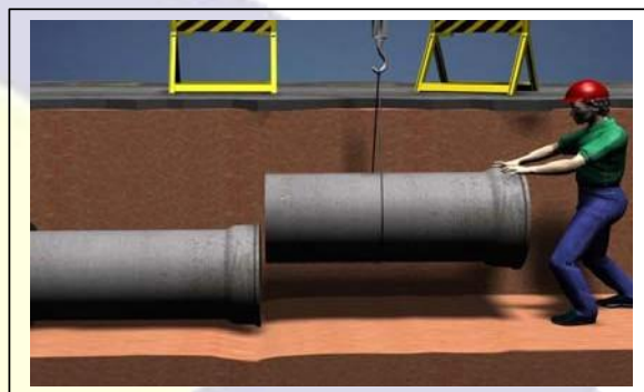
Figura 3 – Acoplamento de tubos de concreto
