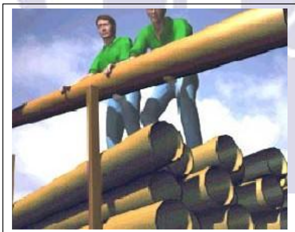
Fig. 01. Descarga manual de tubos de PVC
