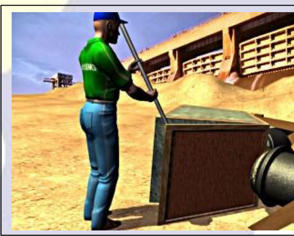
Fig. 05. Desforma do bloco
