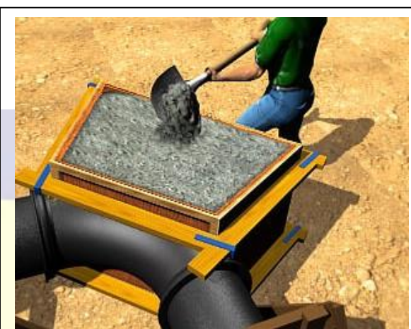
Fig. 04a. Concretagem do bloco
