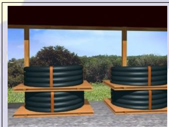
Fig. 05. Estocagem de bobinas
