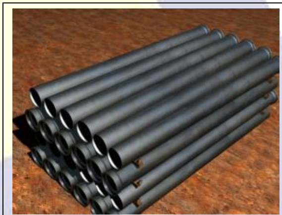
Fig. 03. Armazenagem do tipo “sobreposto”, com bolsas em sentido alternado.
