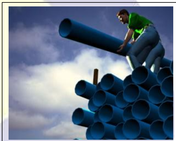
Fig. 01.Descarga manual de tubos de PVC
