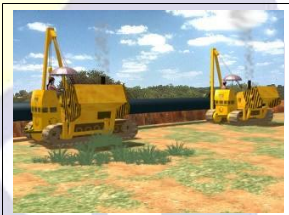
Fig. 03 - ... devendo permanecer içados até que estejam devidamente posicionados e travados.
