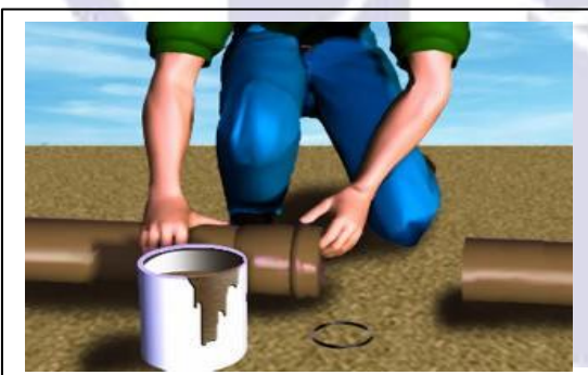
Fig. 03- Aplicação da pasta lubrificante
