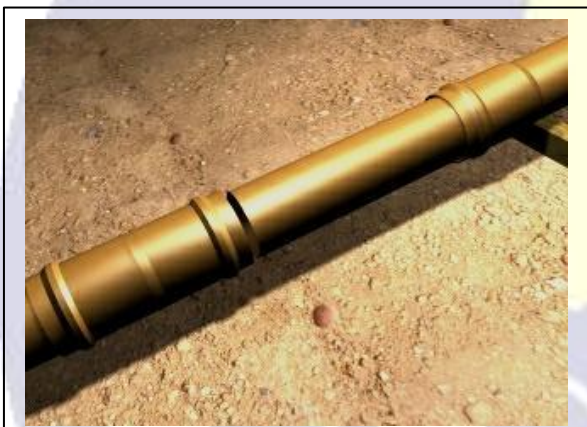
Fig. 13 - O pedaço de tubo será conectado à bolsa a jusante.
