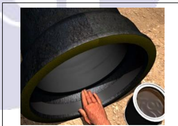
Fig. 07 - Aplicação do lubrificante
