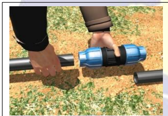
Fig. 45 - O tubo será posicionado e encaixado na bolsa da conexão.
