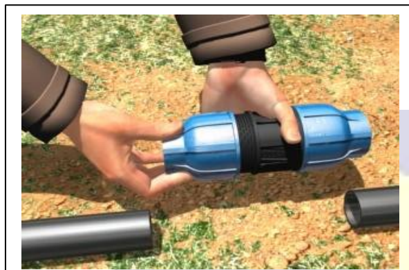
Fig. 44 - A porca da extremidade será desapertada, não havendo necessidade de soltá-la inteiramente.
