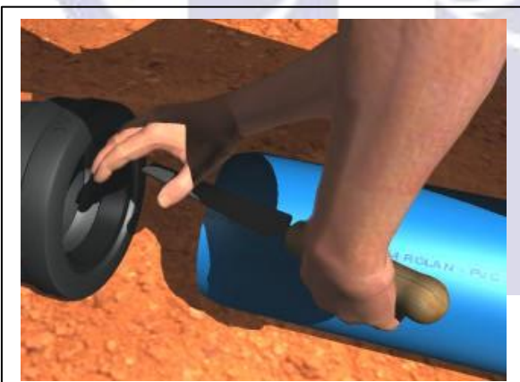
Fig. 10b - ...verificado seu chanfro, para facilitar o encaixe e evitar danos ao anel.
