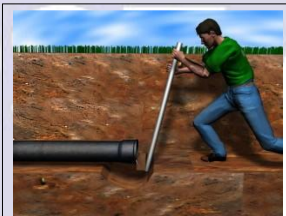
Fig. 11 - Para diâmetros até 100mm, a montagem poderá ser feita com o auxílio de uma alavanca atuando sobre a bolsa do tubo a ser conectado. Deverá ser utilizada uma proteção de madeira entre a bolsa e a alavanca.
