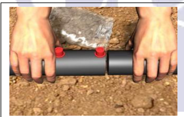
Fig. 31 - A conexão será, então, retirada da embalagem, tomando-se a precaução de não se tocar na região interna da peça, onde está a resistência elétrica. Em seguida, a luva será encaixada, observando-se a marcação efetuada, que indicará a profundidade da bolsa até se chegar ao batente da conexão.
