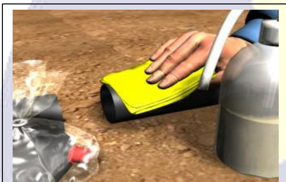
Fig. 30 - A região raspada deverá ser limpa com solução à base de acetona.
