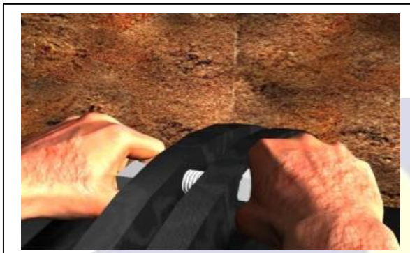
Fig. 06 - Colocação dos parafusos e porcas
