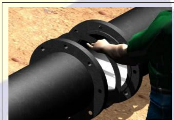
Fig. 05 - Colocação da arruela
