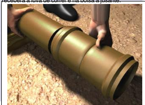
Fig. 11 - Montagem de luva de correr
