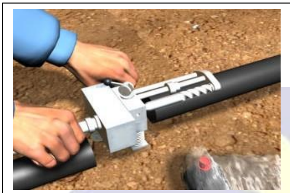
Fig. 29 - Toda a área de contato entre os tubos e a conexão deverá ser raspada com um raspador manual ou mecânico
