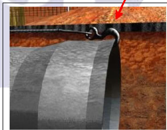
Fig. 10 - ..... podendo, ainda, um dos cabos do tirfor ser conectado diretamente à bolsa do tubo macho.
