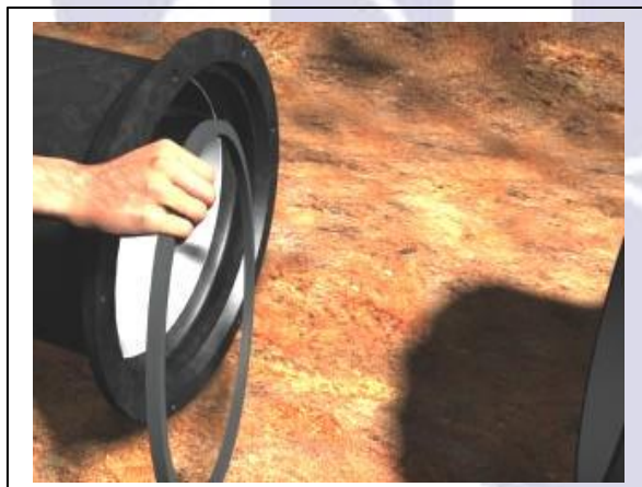
Fig. 03a - Observar o sentido correto do anel de borracha ...
