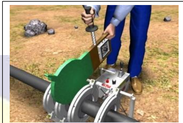
Fig. 23 - Quando a temperatura da placa da aquecimento estiver no valor recomendado pelo fabricante do tubo, a mesma deverá ser posicionada, mantendo-se a pressão de solda até a formação de um cordão inicial entre a placa e o tubo.
