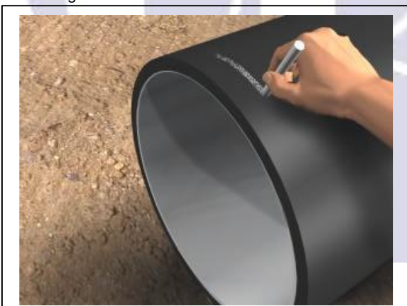
Fig. 05 - Deverá ser feita uma marca, com giz, na ponta do tubo, ...
