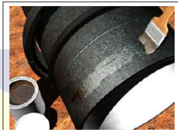
Fig. 07b - ... O lubrificante deverá ser aplicado com pincel.
