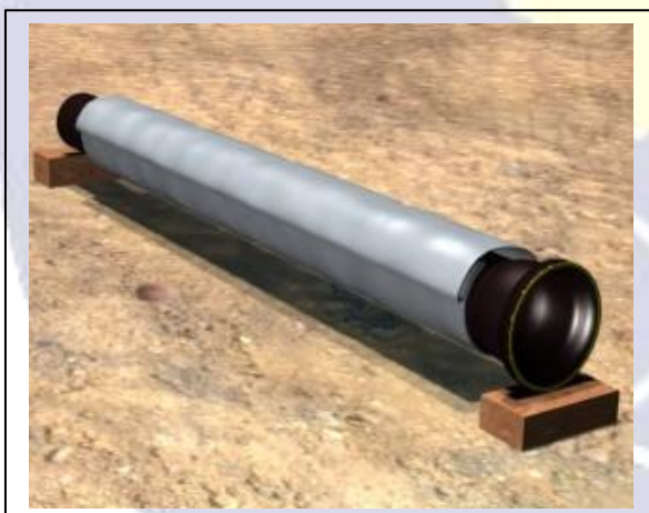
Fig. 09 - COLOCAÇÃO DA MANTA NO CORPO DO TUBO
