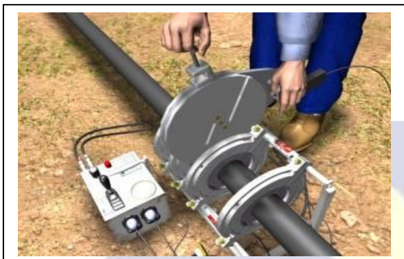
Fig. 20 - Como o uso do faceador, as superfícies deverão ser aplainadas.
