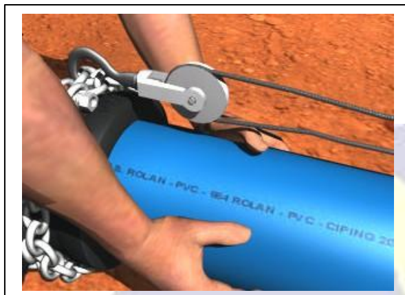
Fig. 12c - ...cuidando-se para que não ocorram danos à bolsa da conexão.
