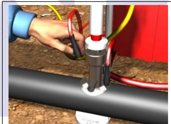
Fig. 40 - O cabo da máquina deverá ser conectado aos bornes do tê.
