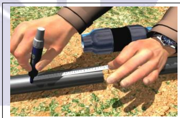
Fig. 43 - Com o auxílio de uma caneta, será marcado nos tubos o valor medido.
