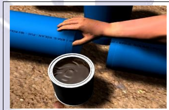
Fig. 03 - Aplicação da pasta lubrificante A pasta lubrificante será aplicada sobre o anel já posicionado e sobre a ponta do tubo a ser conectado. Não deverão ser utilizados óleos e graxa, pois poderão danificar o anel de borracha.
