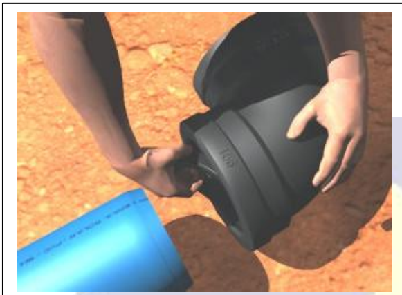
Fig. 09 - Colocação do anel de borracha O anel de borracha será introduzido no sulco da bolsa.
