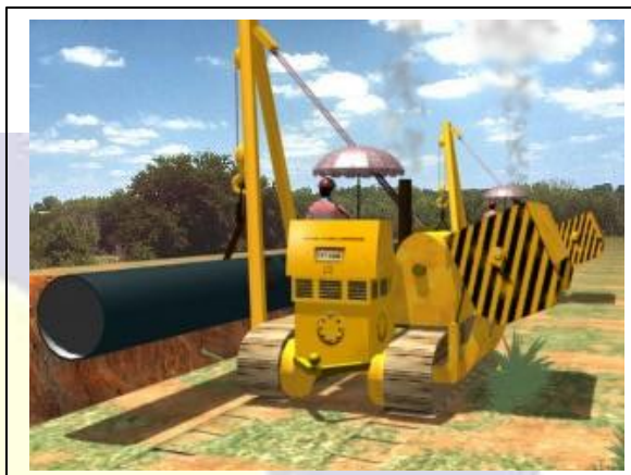
Fig. 02 - Os tubos deverão ser colocados na vala com o auxílio de equipamento mecânico adequado, ...
