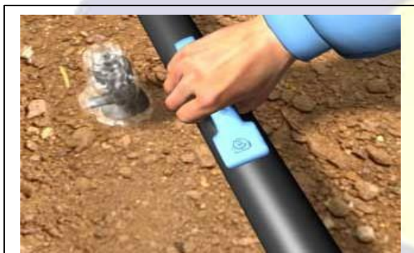
Fig. 36 - O tê deverá ser colocado de volta em sua embalagem e a região demarcada deverá ser raspada manualmente.
