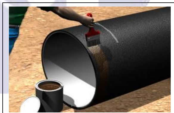
Fig. 05b - ... no chanfro e na ponta do tubo macho, até a marcação. O lubrificante deverá ser aplicado com pincel.
