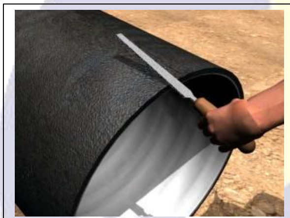
Fig. 04- Preparação das pontas
