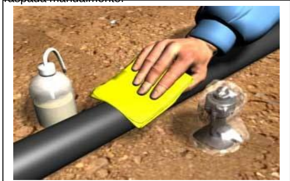
Fig. 37 - A região raspada deverá ser limpa com solução à base de acetona.
