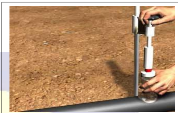
Fig. 38 - Com o auxílio de um pedestal de fixação, o tê de serviço deverá ser posicionado na região demarcada.
