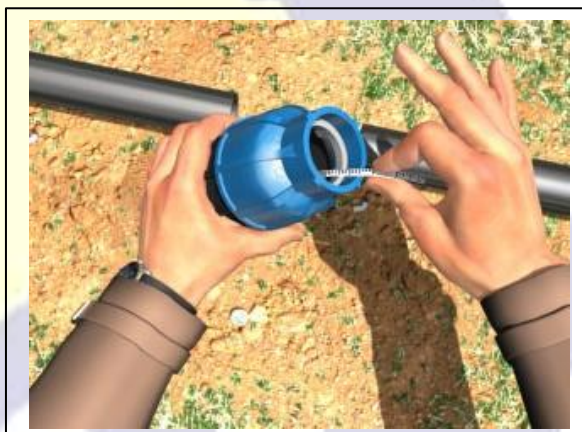
Fig. 42 - Com a porca de extremidade apertada, deverá ser medida a profundidade da bolsa da conexão.
