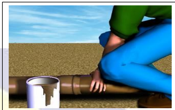
Fig. 04- Conexão dos tubos
