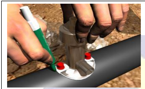
Fig. 35 - Com uma caneta, deverá ser marcada, no tubo, a região a receber o tê.
