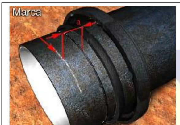
Fig. 06 - Marcação da profundidade de penetração
