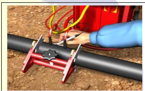
Fig. 33 - Os dados sobre a forma de soldagem - tensão e tempo - serão obtidos e informados à máquina de eletrofusão através da leitura do código de barras presente em todas as conexões, com o auxílio de uma caneta ótica.
