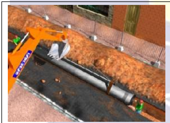
Fig. 05 - Colocação do tubo na vala
