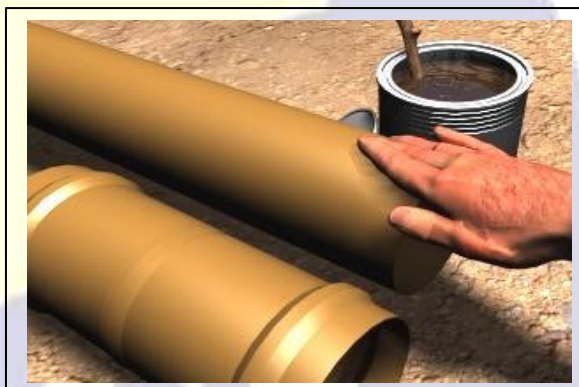
Fig. 10 - Aplicação da pasta lubrificante
