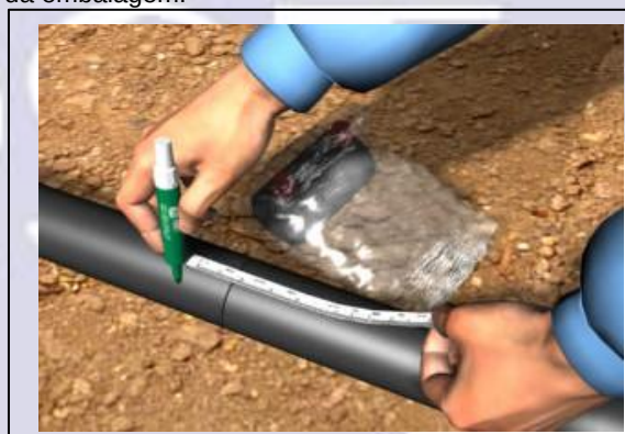
Fig. 28 - Com uma caneta, em cada um dos tubos, deverá ser marcado metade do valor medido.
