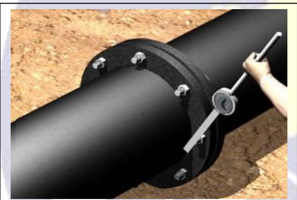
Fig. 07b - ...Será executado um segundo aperto, de forma progressiva, em parafusos diametralmente opostos, garantindo a posição definitiva das peças. Neste caso, recomenda-se que a operação seja feita com o uso de um torquímetro.
