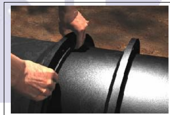
Fig. 05 - Montagem da junta
