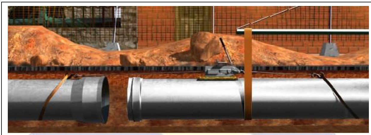
Fig. 09- Colocação do tirfor
