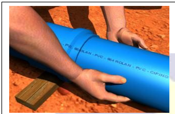
Fig. 04 - Conexão dos tubos
