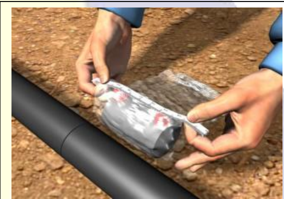
Fig. 27 - Inicialmente, o comprimento da conexão deverá ser medido, sem que a mesma seja retirada da embalagem.
