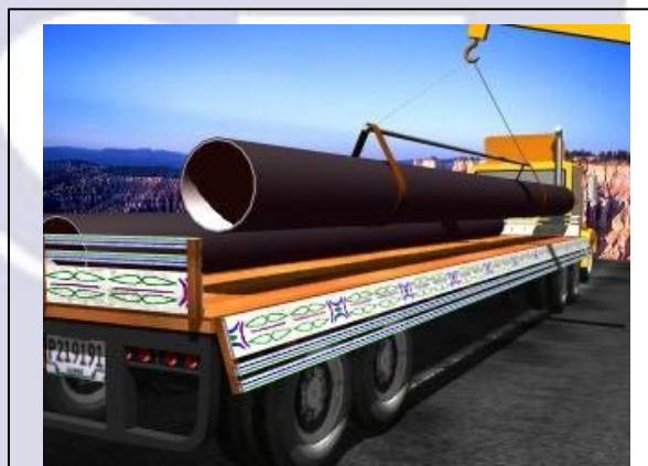
Fig. 09– Manuseio dos Tubos
