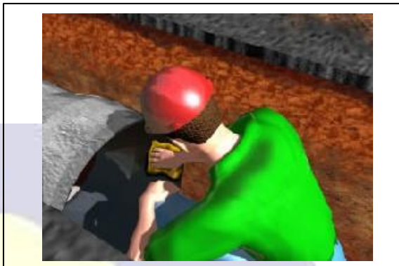
Fig. 06 - Limpeza na região da ponta e bolsa e do anel de vedação
