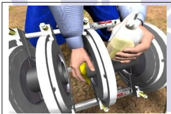
Fig. 22 - As superfícies deverão ser limpas com uso de solução a base de acetona.
