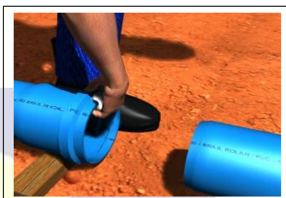
Fig. 01 - Limpeza Primeiramente serão limpas a bolsa e a ponta a serem conectadas
