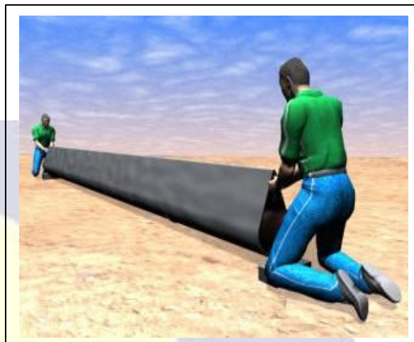
Fig. 10 - Deverá ser assegurado que a dobra seja feita na geratriz superior do tubo, a fim de eliminar os riscos de danos que podem ocorrer, durante o recobrimento da canalização, devido à penetração de terra na dobra.
