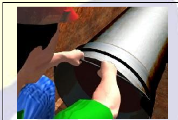
Fig. 07 - Colocação de anel de vedação JE
