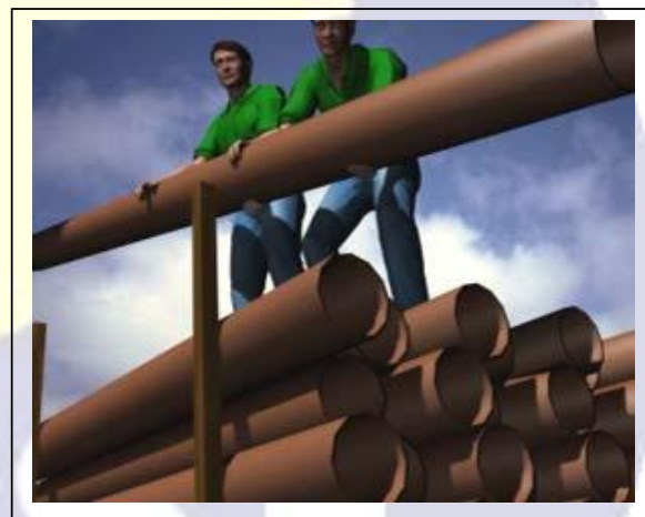
Fig. 01. Descarga manual de tubos de PVC
