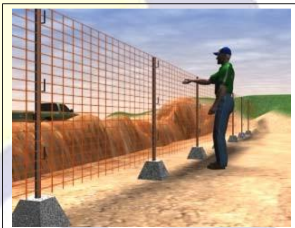
Fig. 01. Proteção de vala com tela de PVC
