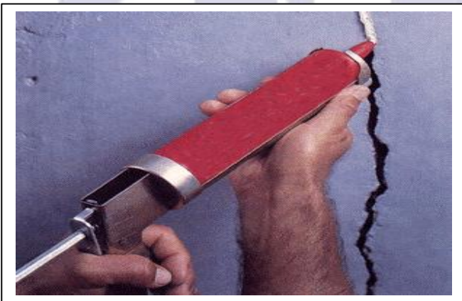
Fig. 09. Preenchimento da trinca
