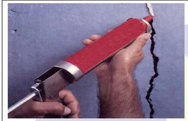
Fig. 09. Preenchimento da trinca
