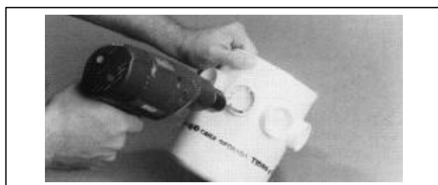
Fig. 09. Abertura dos furos de entrada das caixas
