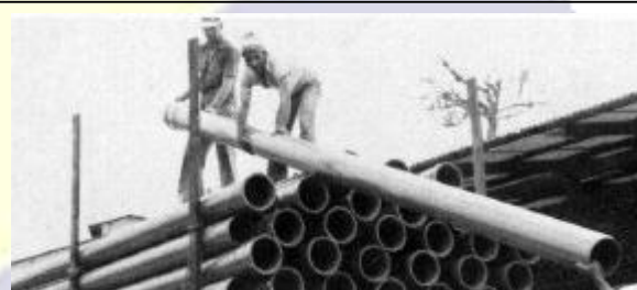
Figura. 01. Carga em caminhão
