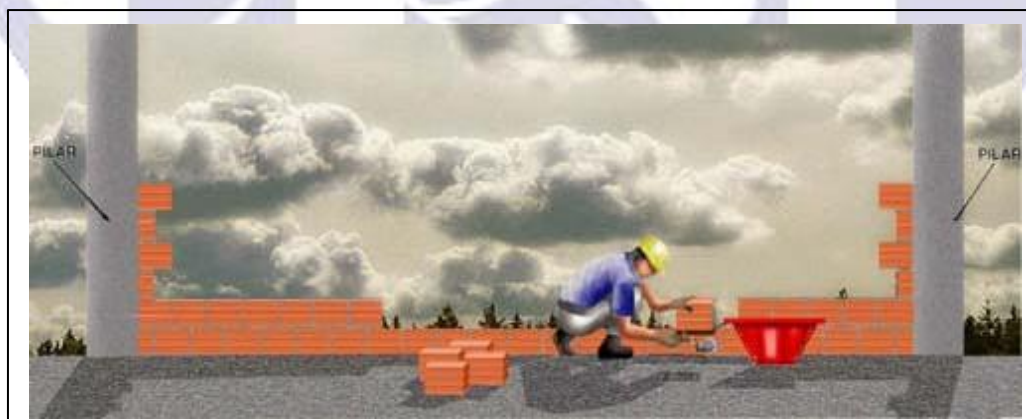
Figura 50. Assentamento de Alvenaria 01
