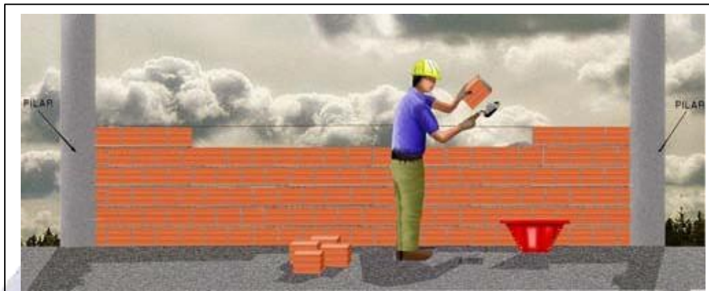
Figura 51. Assentamento de Alvenaria 02
